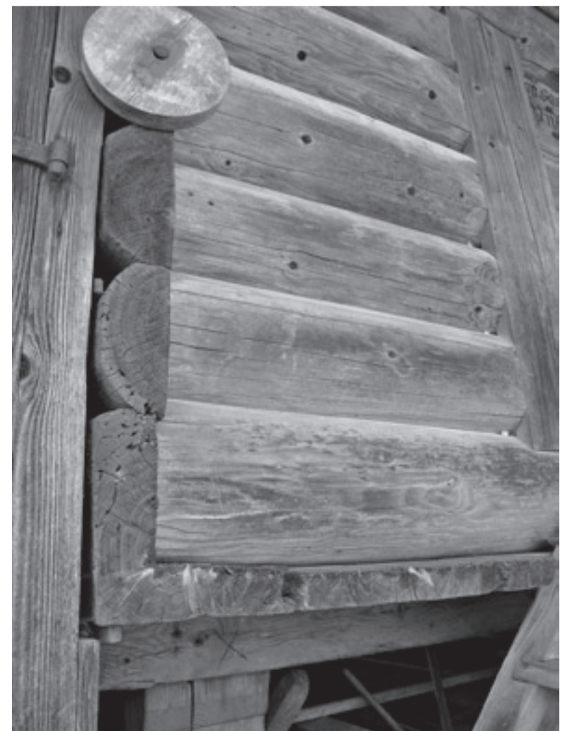
Eckverbindung am Gebäude im Lood 72
