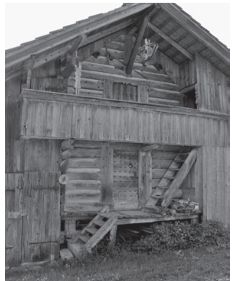
Speicher in Fahrni.
