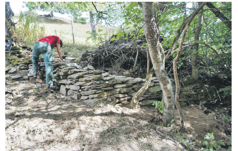
Trockenmauer erhält vom Förster noch den letzten Schliff.
